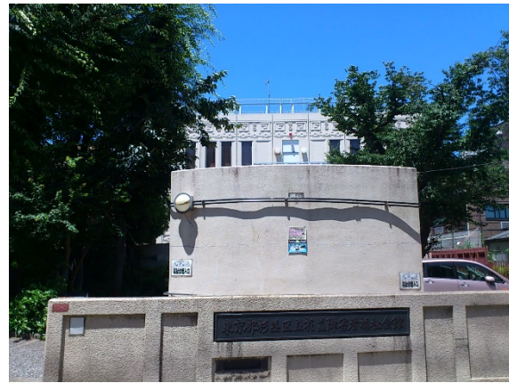
障害者福祉会館(高井戸東4-10-5)
