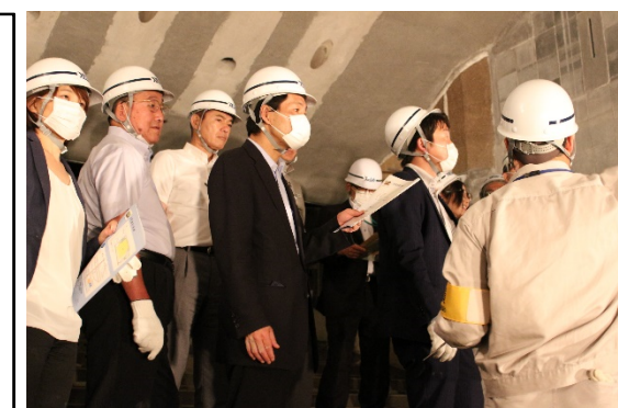
焼却炉内を視察
